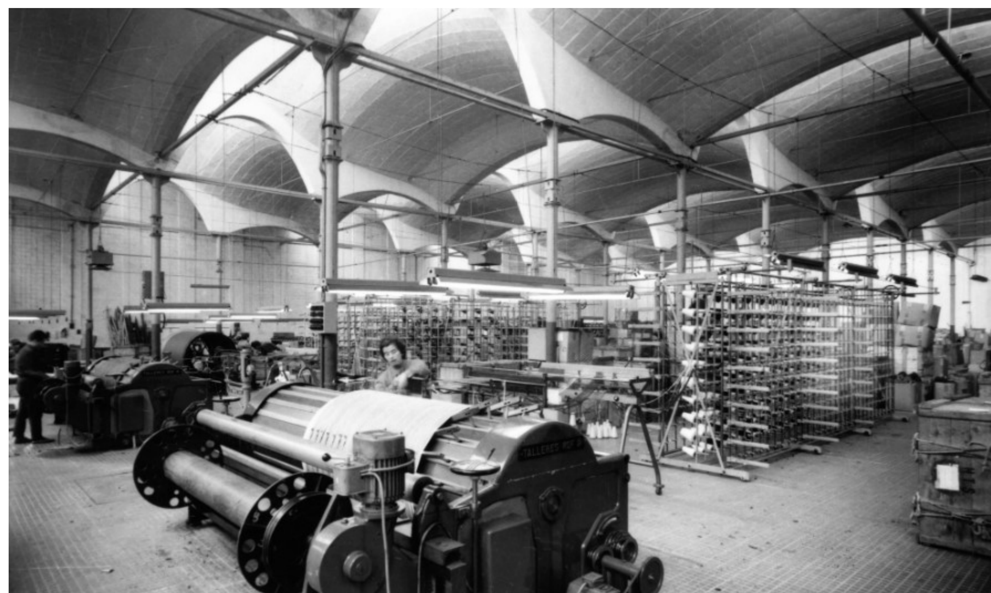
Fàbrica Aymerich i Amat [Textil]. Data: 01/01/1975 Autor: Desconegut Font: Arxiu Municipal de Terrassa
